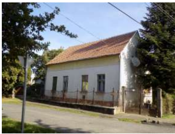
Lakóház Rákóczi Ferenc utca-Árpád utca elágazása (1147 hrsz)
